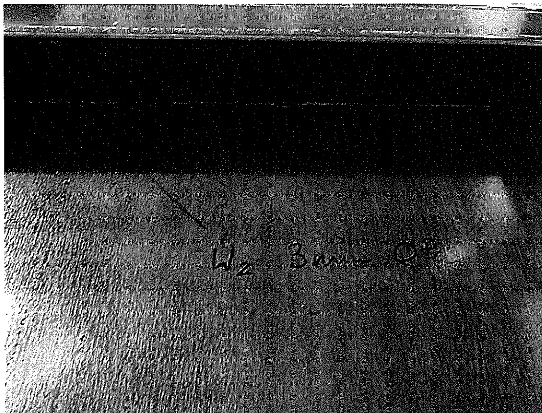
Fot. 14. Przekiek W2.
